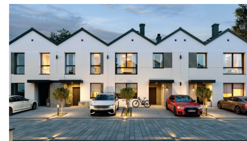
Widok budynku od strony ulicy
